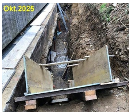
Verlegung neuer Leitungen
