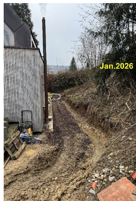
nach der Verfüllung der Baugrube
